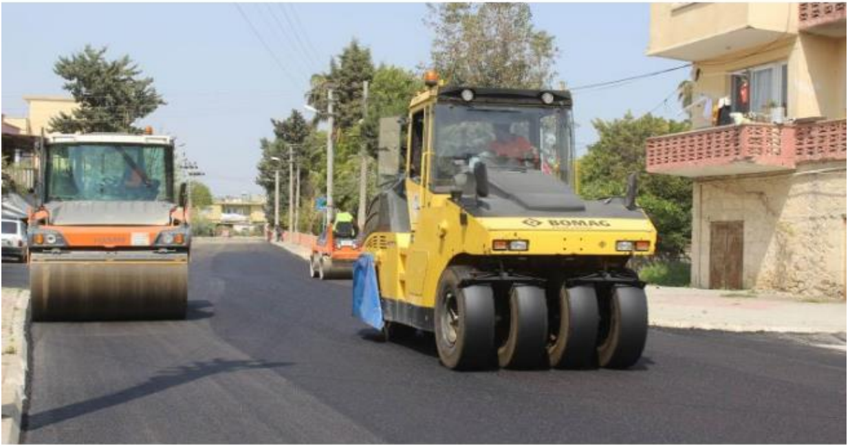
KAZANLI MAHALLESİ'NDE 3 CADDEDE ASFALT ÇALIŞMASI
